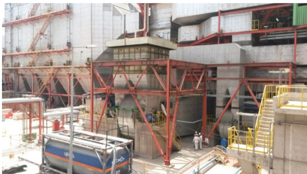
Ilustración 9-12: Precipitador electrostático
