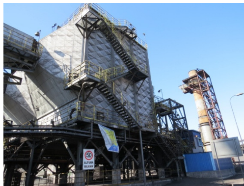
Ilustración 9-17: Precipitador electrostático en Chimenea 2A; al fondo se ve la chimenea
