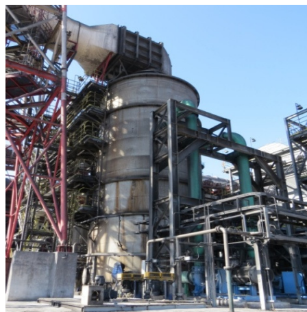
Ilustración 9-5: Scrubber en CAP
